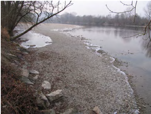
Bild 8.15 Während dem Hochwasser vom August 2005 hat sich aus den drei geschütteten Kiesbänken eine langgezogene Kiesbank gebildet, die die grobkörnige Sohle der Flachwasserzone teilweise überdeckte.
