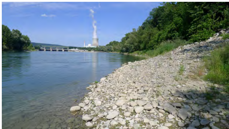
8.18 Kegelförmiger Schüttkörper bei LZ 5 mit aufkommendem Bewuchs. Blick gegen Fließrichtung.
