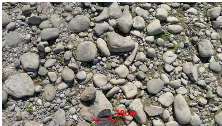
Bild 8.19 Detail des grobkörnigen, kolmatierten Schüttmaterials im Bereich der Wasserlinie.
